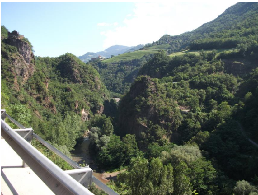
Von Bozen geht es ein wilde Schlucht entlang durch mehrere Tunnels hinauf in eine Hochebene.
